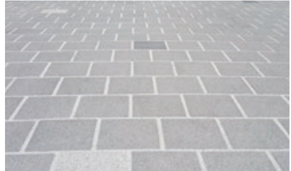
대일텍 3D-HOLE블록 시공사진
